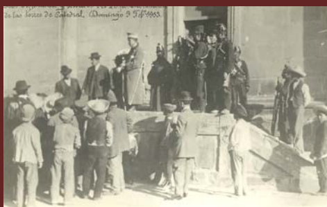
Los aspirantes del 20 posesionados de las torres de Catedral. Domingo 9 de Feb.. 1913.
